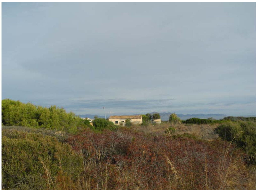
Fotografia 6. EDAR de la Colònia de Sant Pere des dels terrenys de l'alternativa 1, situats al sud.
